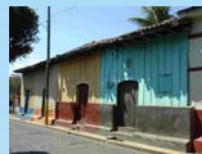
Figure 3. MF - 'Minifalda' (madero y concreto)
