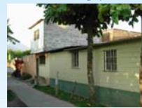
Figure 11. CBu - Bloques de concreto no reforzados.
