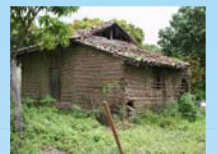
Figure 6. BH - 'Bahareque/bahareque' (madera mezclada, bambú y construcciones de muros de tierra).
