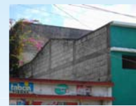
Figure 13. CBrc - Bloques de concreto confinados.
