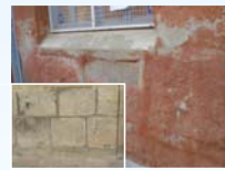
Figure 15. PdC - 'Piedra de Cantero' Mampostería de piedras de cantera no reforzada.
