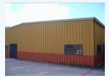
Figure 18. LT - 'Laminada Troquelada' Marcos de acero con placas de acero corrugados.
