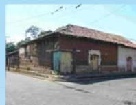
Figure 4. AD - Mampostería de adobe con mortero de adobe.
