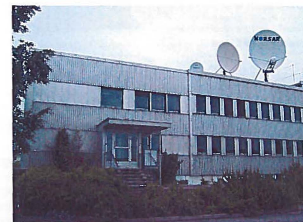
NORSARs hovedkontor og datasenter på Kjeller. NORSAR's main office facilities and data center at Kjeller.
