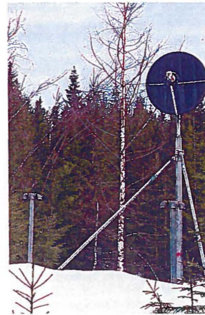
VSAT-antenne for satellittoverføring av data fra PS27 stasjonen NAO i Nes i Hedmark til NORSARs datasenter på Kjeller.
